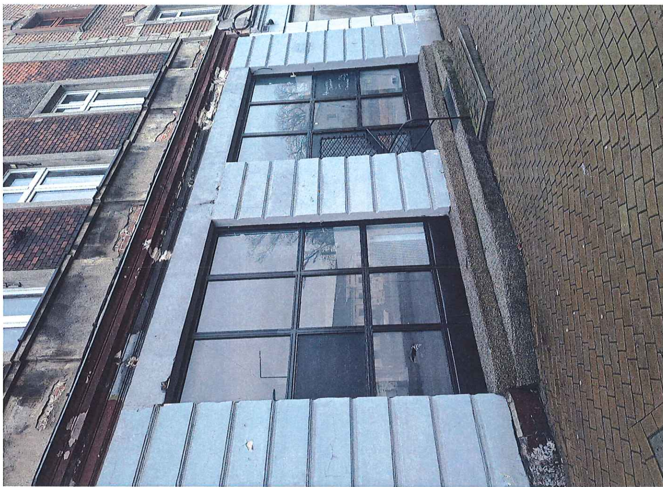
ul. Zabrska 18/u-1 , parter - front budynku
